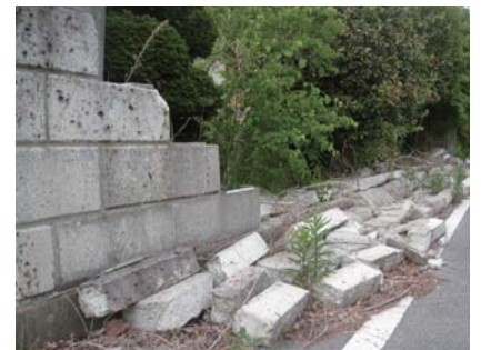
地震により石塀が倒壊
