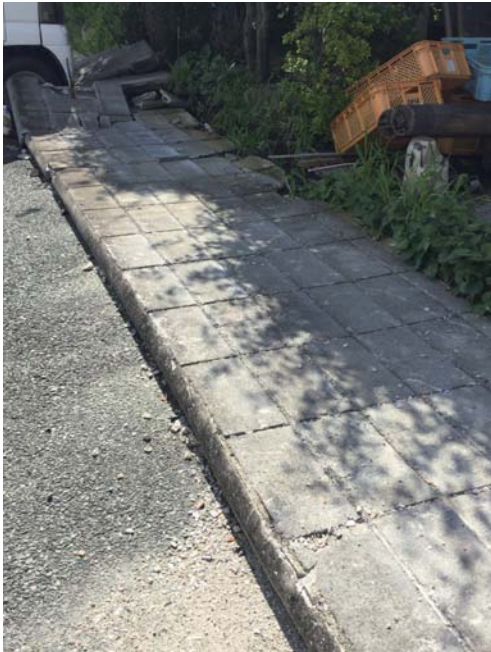
地震によりブロック塀が倒壊
